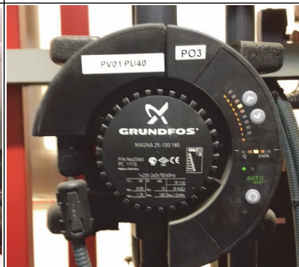
Patteriverkoston kiertovesipumppu
