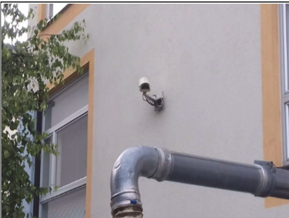
Julkisivuun asennettu valvontakamera
