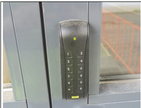
Kulunvalvontajärjestelmän koodinäppäimistö
