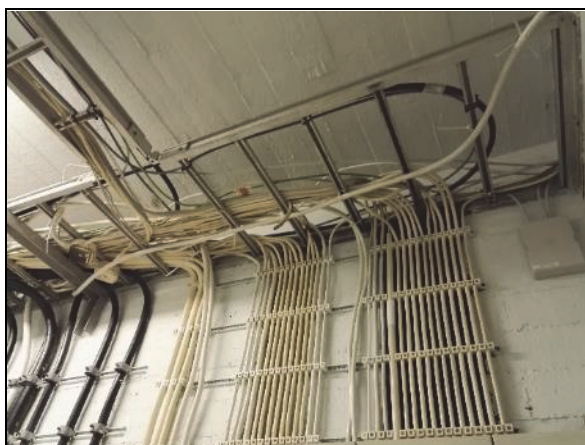
Sähköpääkeskushuoneen tikashyllyt
