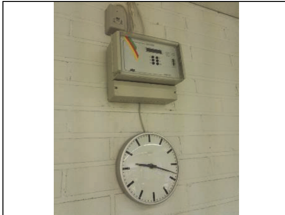
Ajannäyttöjärjestelmän keskusyksikkö ja pääkello.
