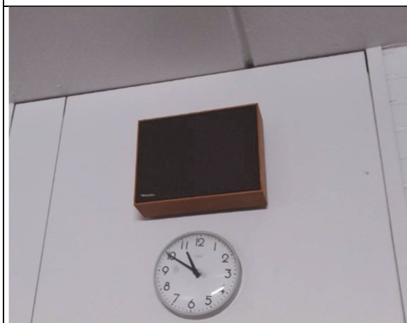
Alkuperäinen luokkahuoneen keskusradion kaiutin.
