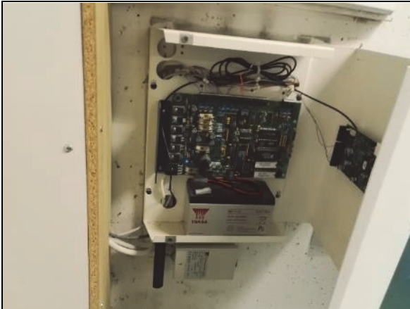
Ovilukitusjärjestelmän pääyksikkö.
