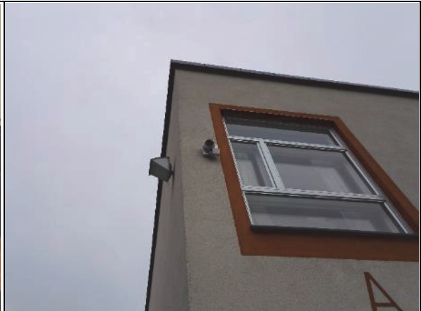
Julkisivuun asennettu valvontakamera
