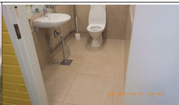
C osan WC tilat on remontoitu 2014
