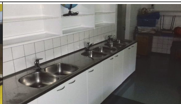
A-rakennuksen luokkahuoneen yksiotehanat jairst-taso
